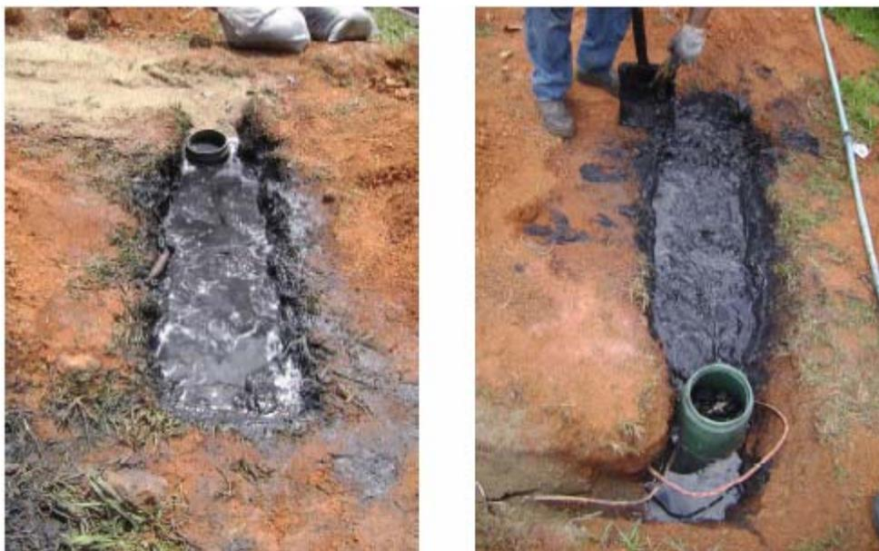
Figura 3.2 Fosa rellenas con material acondicionador
