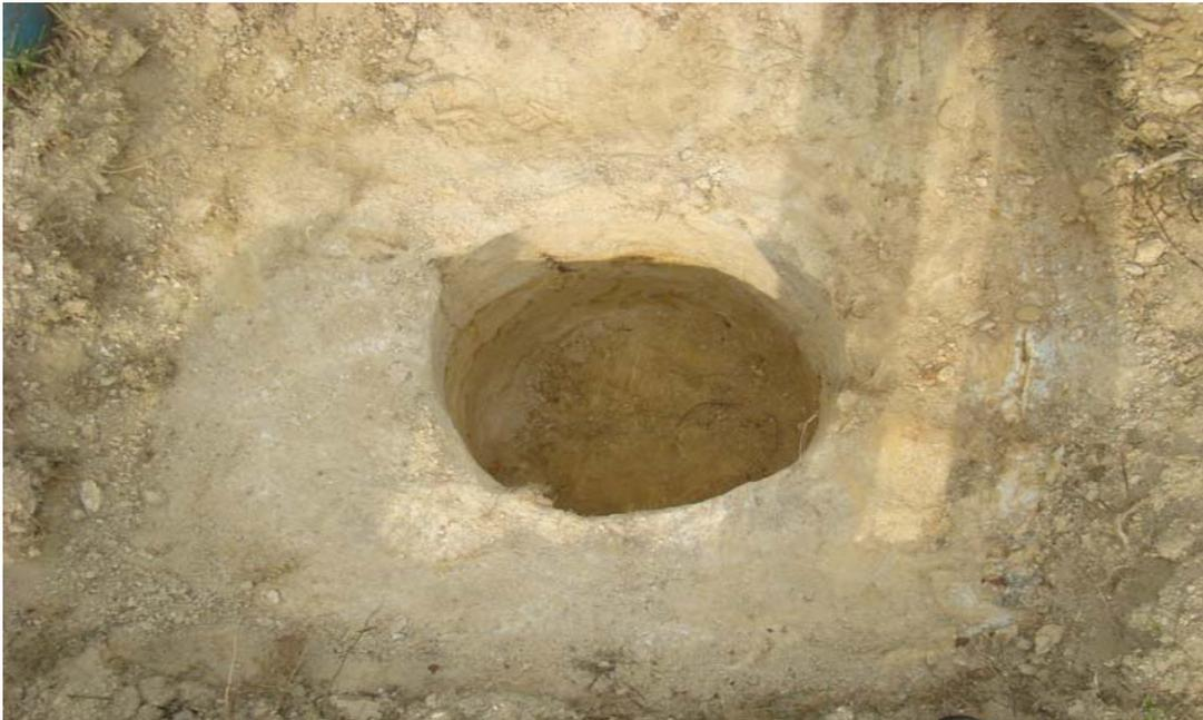
Figura. 3.13. Apertura de una fosa circular de 50 cm de diámetro y 50 cm de profundidad.
