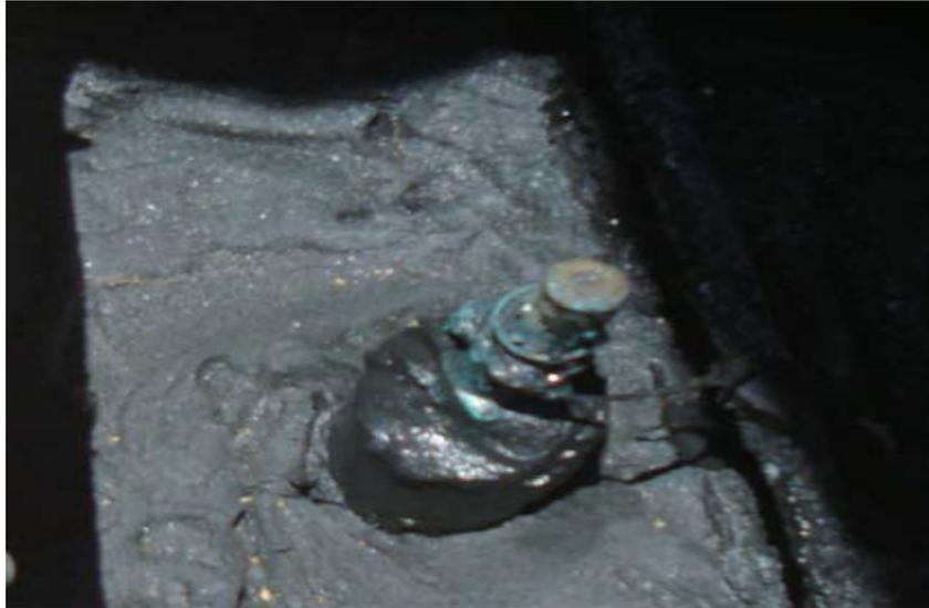
Figura 3.25. Oxidación de las partes metálicas de la instalación, debido al gran contenido de sal del acondicionador.
