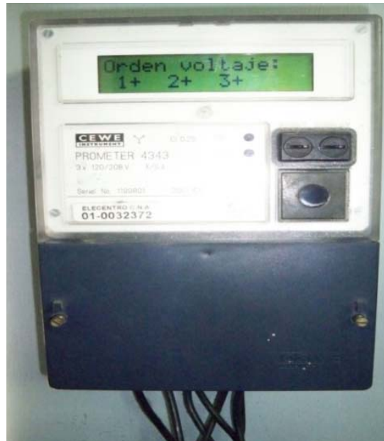
Figura: 3.1 Contador Patrón de Energía CEWE ProMeter 4343.
