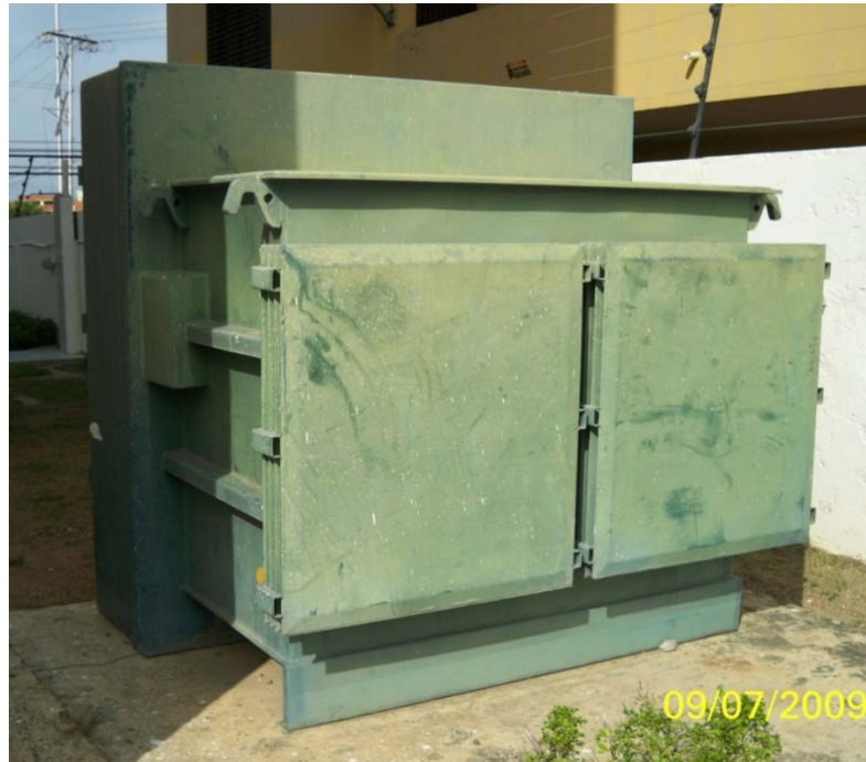
Figura: 2.1 Transformador de Distribución 300 KVA tipo (Pedestal).
