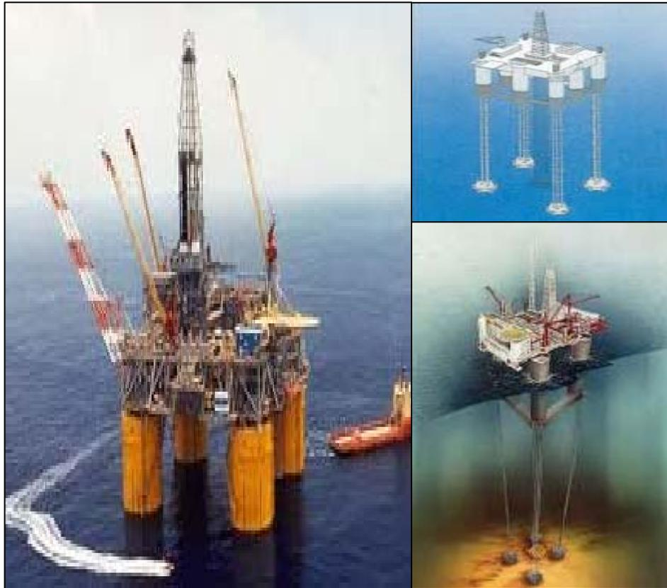
**Figura 2.13.** Plataforma de Patas Tensionadas.
