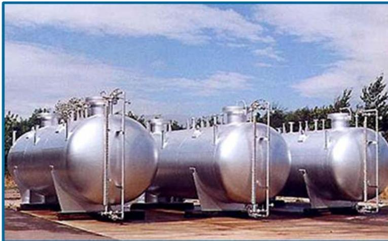
**Figura 2.4 Tanques presurizados cilíndricos**
