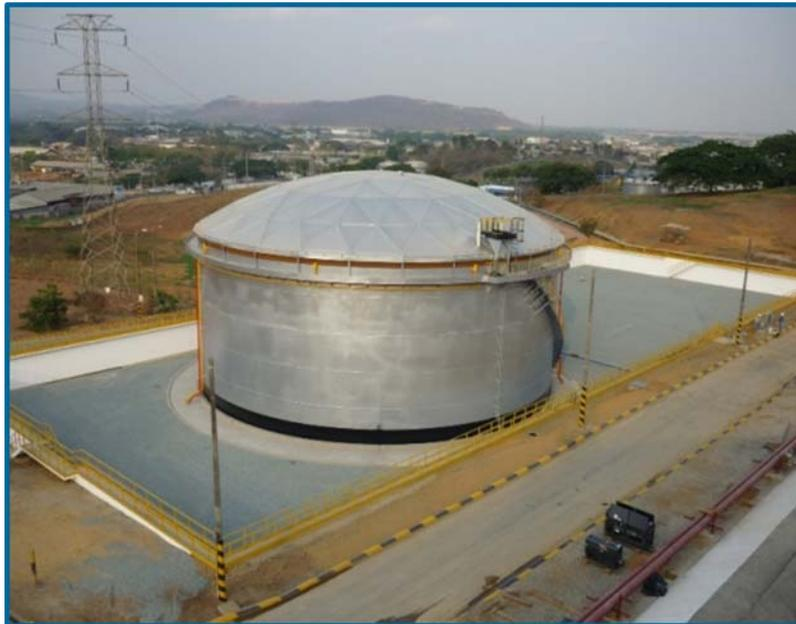
**Figura 2.2 Tanque de techo flotante cerrado**
