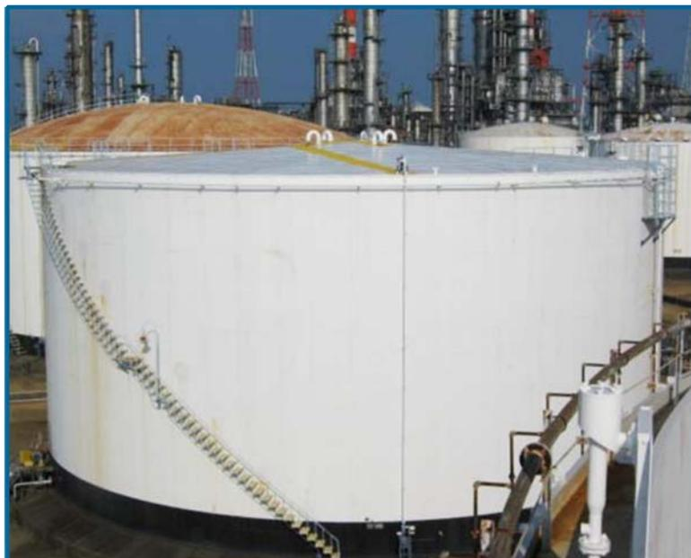
**Figura 2.1 Tanque de techo cónico**
