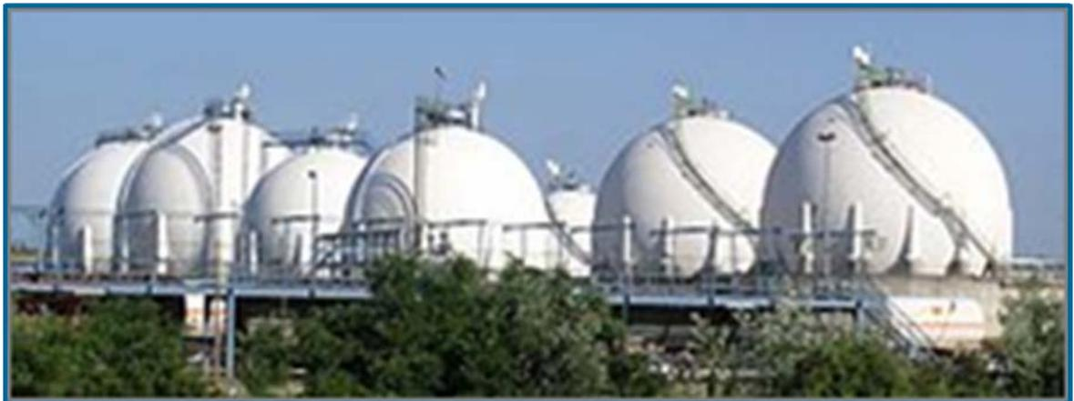
**Figura 2.5 Tanques presurizados esféricos**
