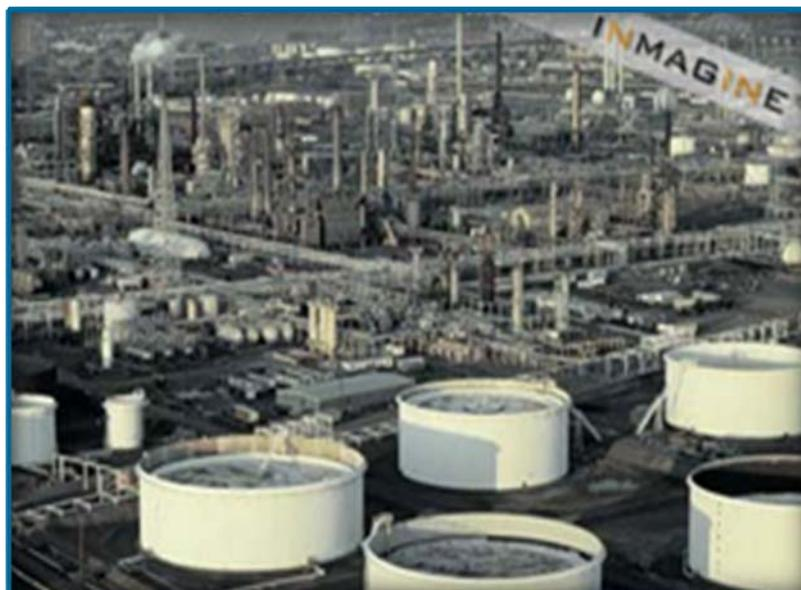
**Figura 2.3 Tanques de techo flotante abierto**
