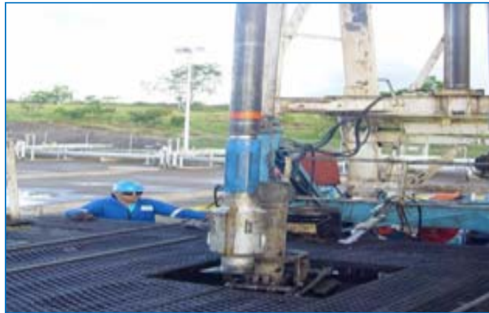
Figura 2. 20. Instalación de Bomba 400 MET 1000 en la Faja del Orinoco.
