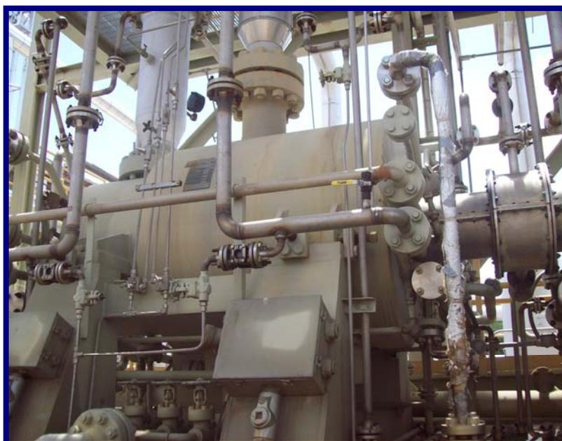
**ANEXO B.6** Compresor centrífugo (RECAT Anaco)
