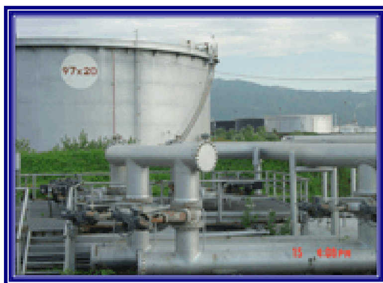
Figura 4.1 Tanque 97x20, Refinería PLCR.
