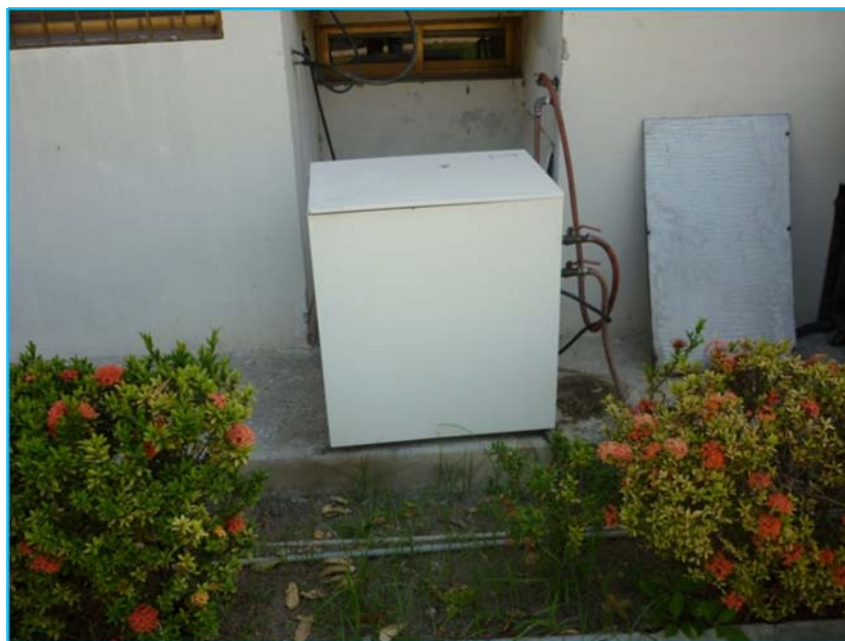
Fig. 29: Unidad de enfriamiento del equipo de Difracción de Rayos X.
