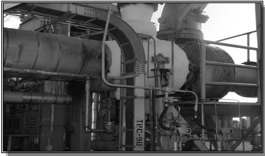
Fig. N° 2.4 Turboexpansor [3]
