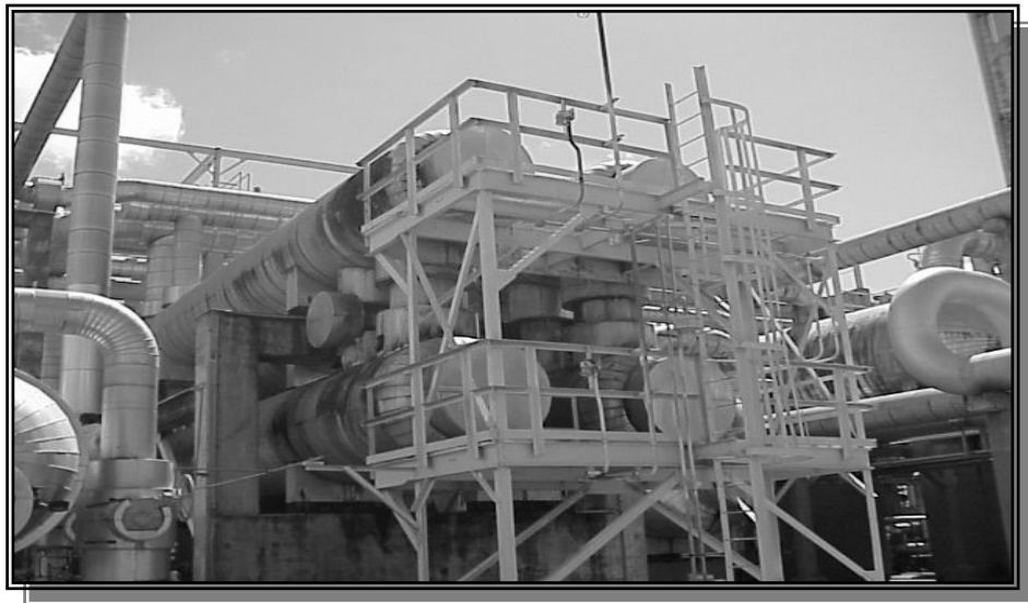
Fig. N° 2.19 Intercambiador gas frío/gas de baja presión [20]
