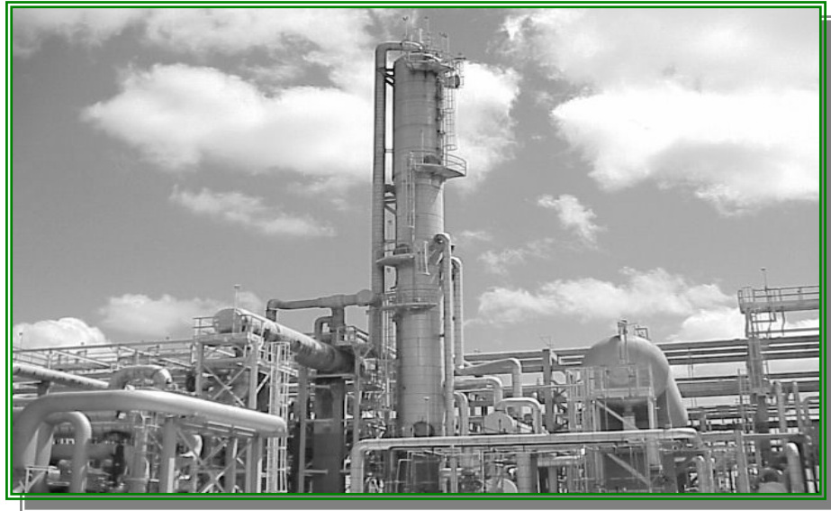
Fig. N° 2.21 Torre Desetanizadora [20]
