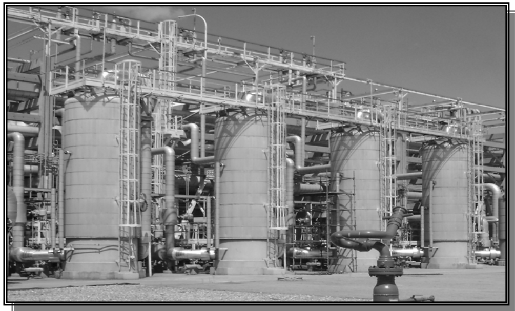
Fig. N° 2.3 Sistema de Deshidratación con Tamices Moleculares [2]
