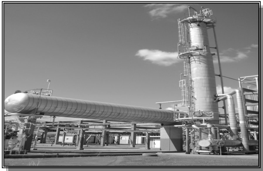
Fig. N° 2.23 Torre estabilizadora de condensado
