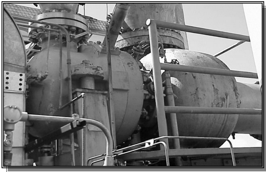
Fig. N° 2.20 Expansor/Precompresor [20]
