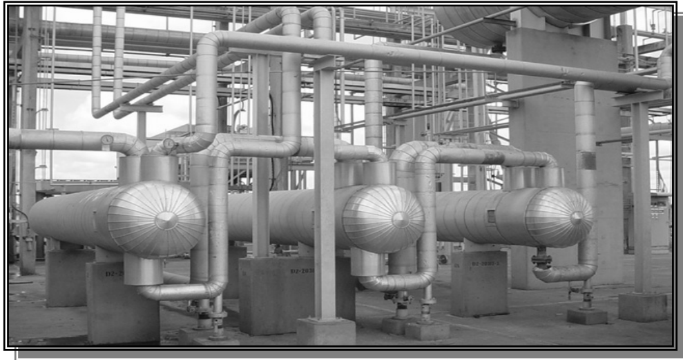
Fig. N° 2.7 Intercambiadores glicol rico/glicol pobre [13]
