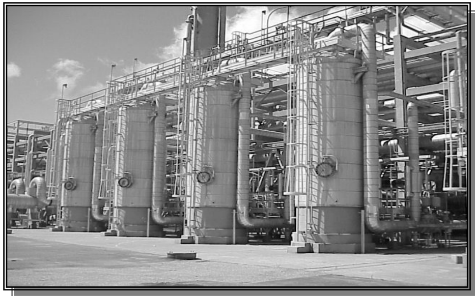
Fig. N° 2.18 Tamices moleculares [20]
