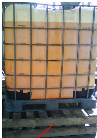
**Paletas colocadas a los tanques de inyección de química para contrarrestar la diferencia de altura en relación a las bombas, ya que tomaban aire y dejaban de inyectar.**
