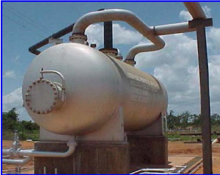
**Figura 2.16. Separador Horizontal.**<sup>[16]</sup>
