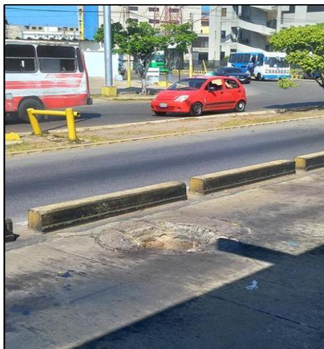
Figura No. 4.9 Presencia de hueco en el canal destinado para el tránsito del BTR
