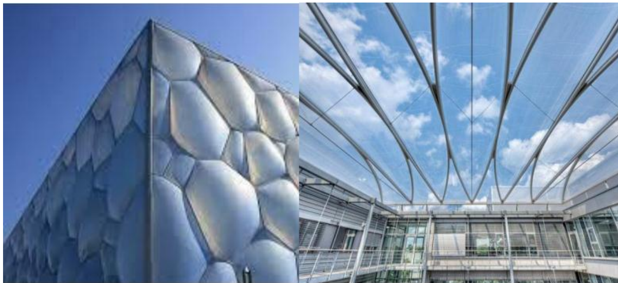
Figura N° 48 Distintas transparencias de membranas ETFE
