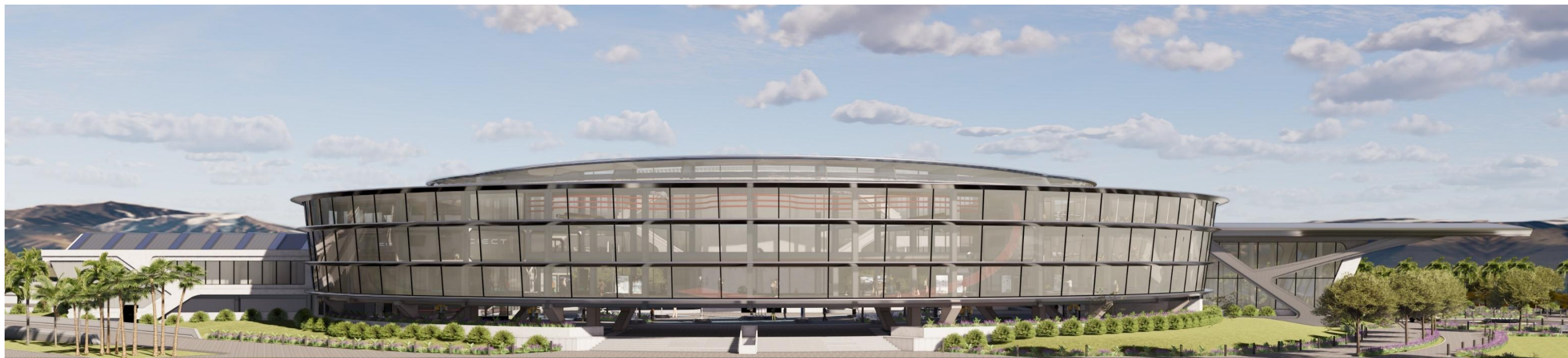
Figura N° 119 Fachada Lateral Izquierda (Noroeste)
