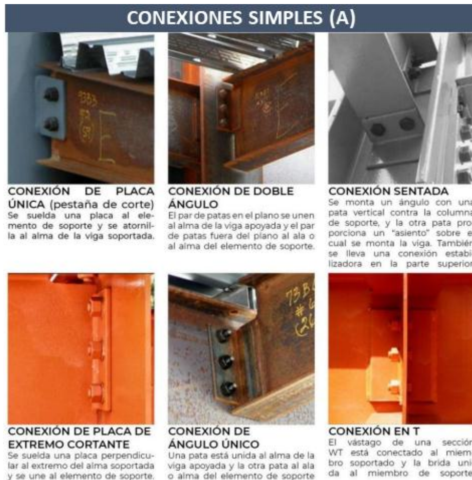
Figura N° 90 Conexiones simples en perfiles de acero
