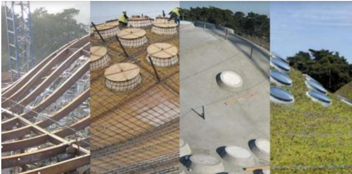
Figura N° 17 Proceso constructivo techo verde, Academia de las Ciencias de California
