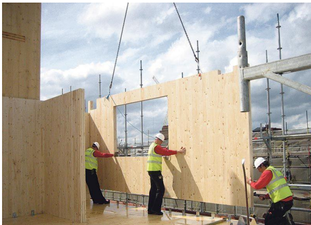
Figura N° 47 Sistema constructivo de paneles contralaminados
