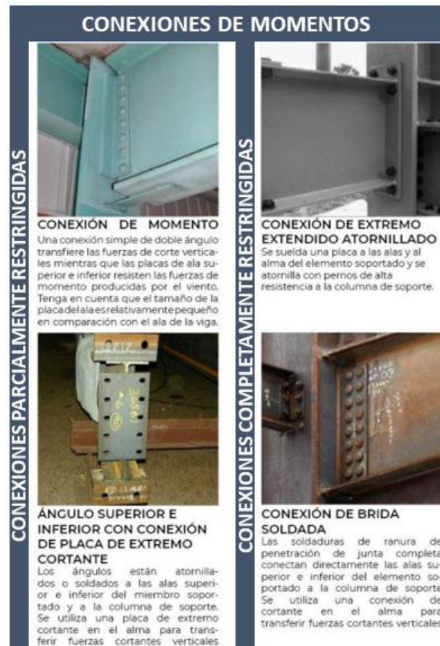
Figura N° 91 Conexiones de momento en perfiles de acero.
