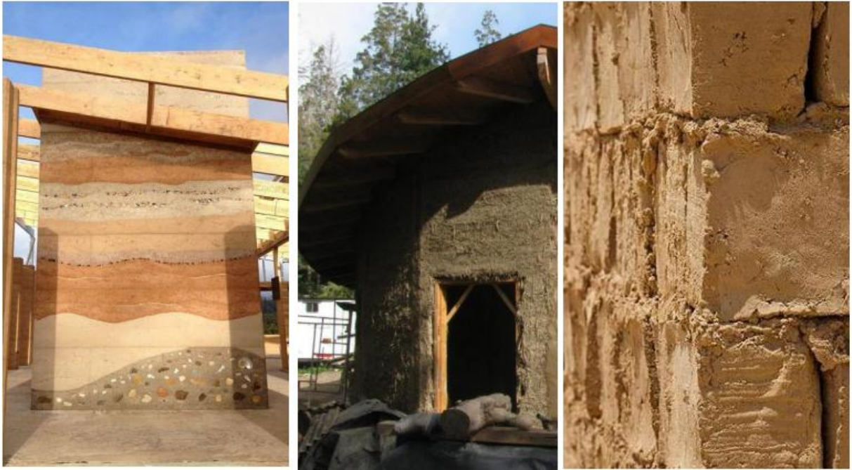
Figura N° 44 Muros apisonados, Cob y Adobe en orden
