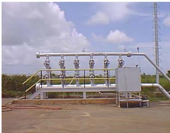
**Figura 2.1.** Múltiple de Producción General y de Prueba.
