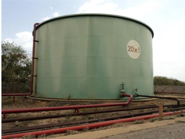
**Figura 4.7. Tanque de almacenamiento de agua (20x1)**
