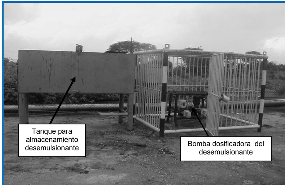
**Figura 2.9 Instalación típica de un sistema de tratamiento químico en una estación de flujo (Mindiola, 2005).**
