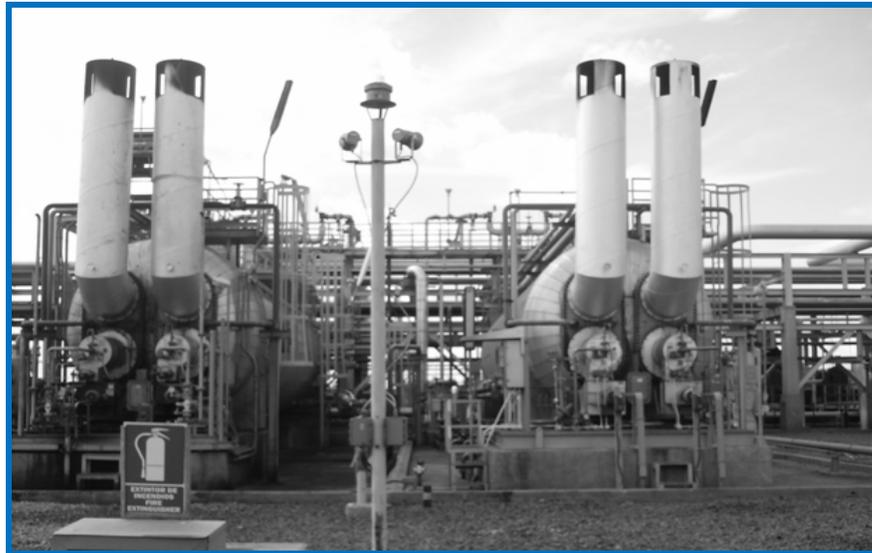
**Figura 2.10 Método mecánico: tratador horizontal (Mindiola, 2005).**
