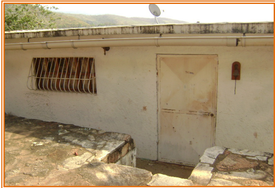
Fig. 4.22 Fachada de vivienda ubicada en Guanta, construida hace aproximadamente 20 años
