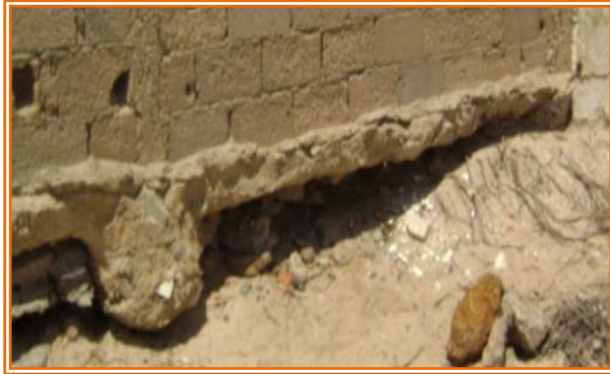
Fig. 4.8 Fundación del muro superficial.
