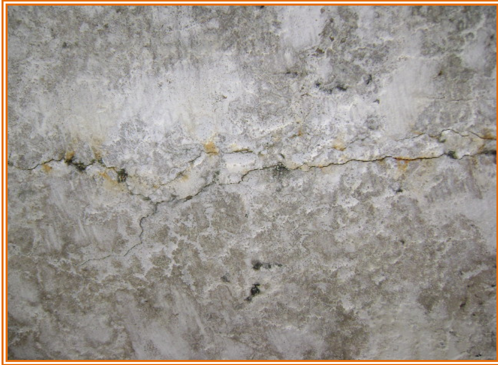
Fig. 5.2 Reacción del nitrato de plata sobre la losa.
