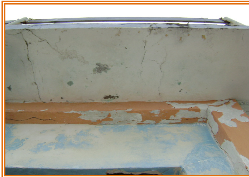
Fig. 4.20 Losa agrietada.
