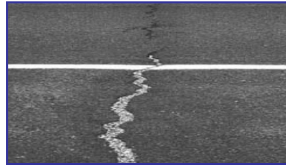
Figura 2.6.5.10.2: Grietas Transversales.
