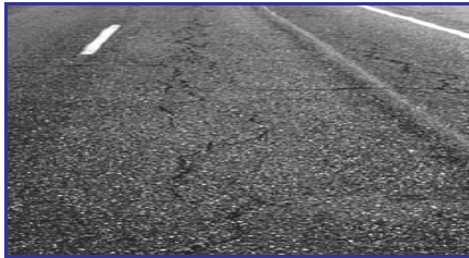
Figura 2.6.5.10.1: Grietas Longitudinales.
