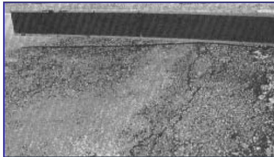
Figura 2.6.5.4: Elevaciones y/o hundimientos.
