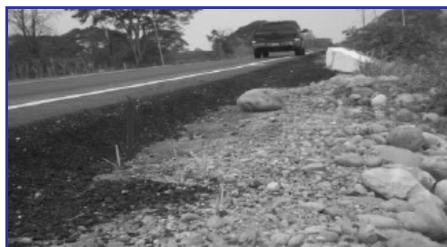
Figura 2.6.5.9: Desnivel calzada - hombrillo.
