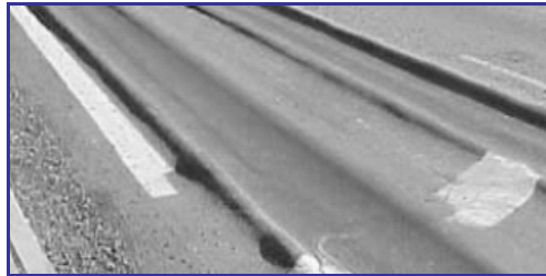
Figura 2.6.5.15: Ahuellamiento.
