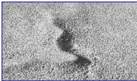
Figura 2.6.5.16: Deformación por empuje.
