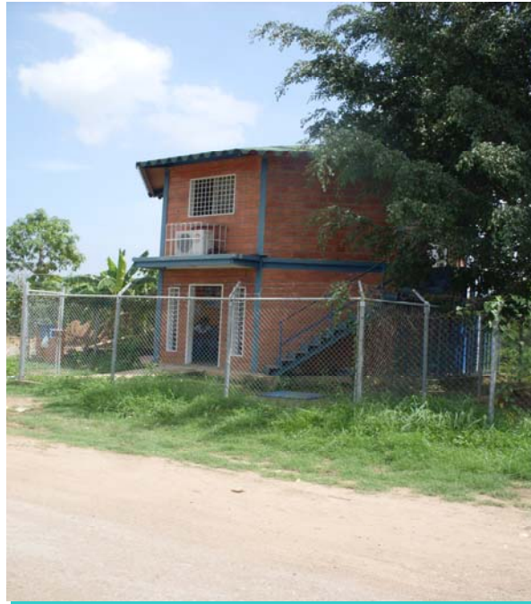
Figura 3.2. Módulo Asistencial Barrio Adentro.
