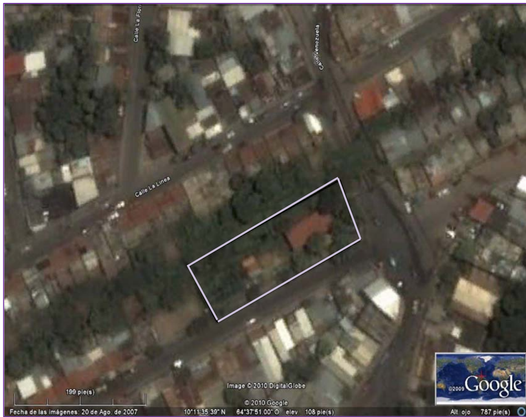
Figura N°4: Imagen Satelital de la Estación de Bombeo “La Caraqueña”
