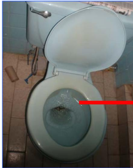
Inodoro con constante bote de agua a causa del tanque dañado.
