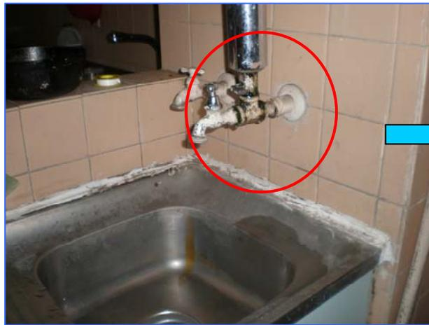
Filtro con constante bote de agua a causa de tubo dañado.
