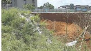
El hundimiento de una vía provocó la rotura del tubo (Sailú Urribarrí)
