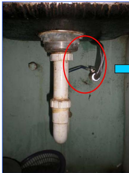
Lavaplatos con constante bote de agua a causa de tubo dañado.
