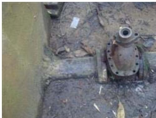
**F.6 Válvula Dañada Ubicada en la Entrada del Tanque de Cloración.**
