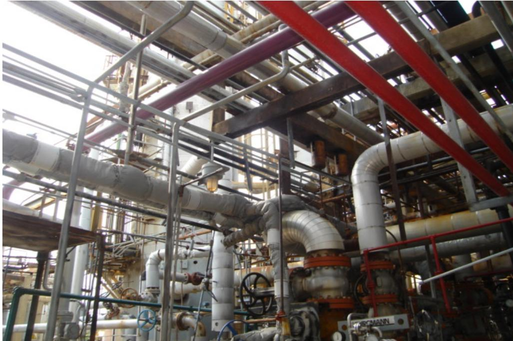
Tuberías apoyadas sobre una de las vigas afectadas por el fuego
