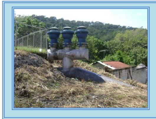
**Figura 3.5 Tubería de Impulsión de la Estación de Bombeo Curaguaro.**
