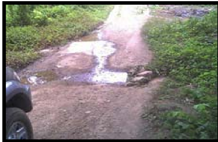
Figura 4.12 Progresiva 0+400. Acondicionamiento de la superficie con la ayuda del tractor.
