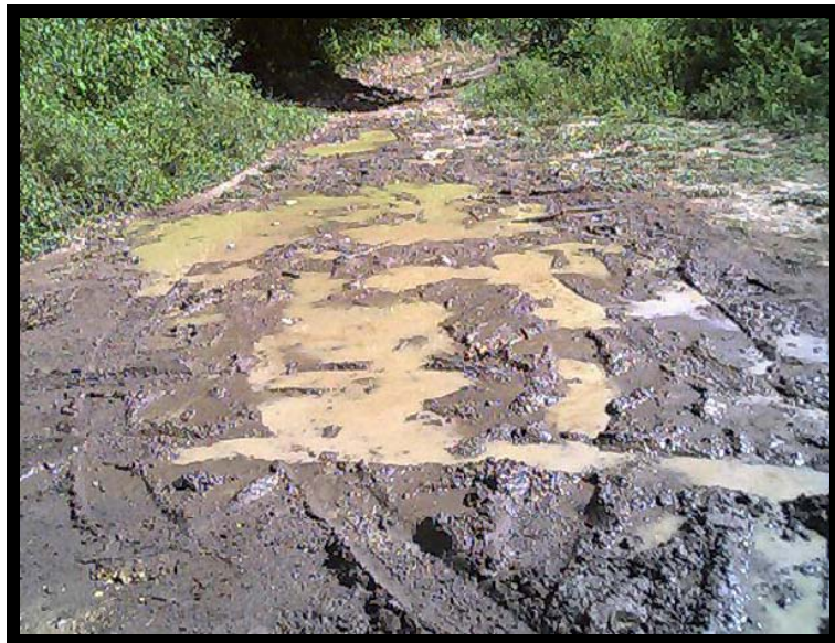
Figura 4.6 Progresiva 0+500, sitio donde se va a construir una batea de concreto armado.
