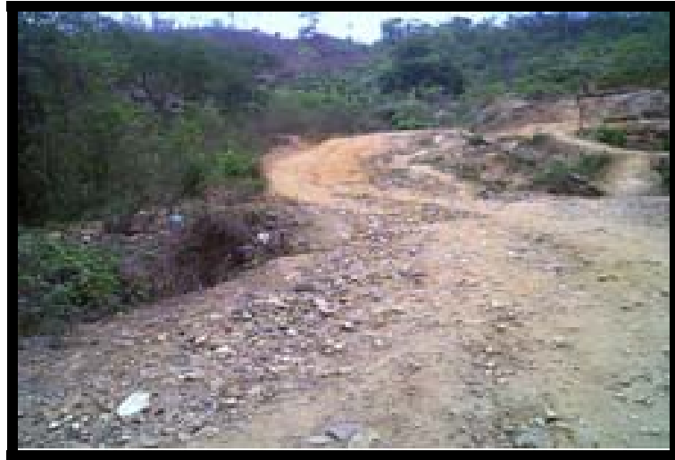
Figura 4.11 Progresiva 4+300. Demolición y construcción de hatea
