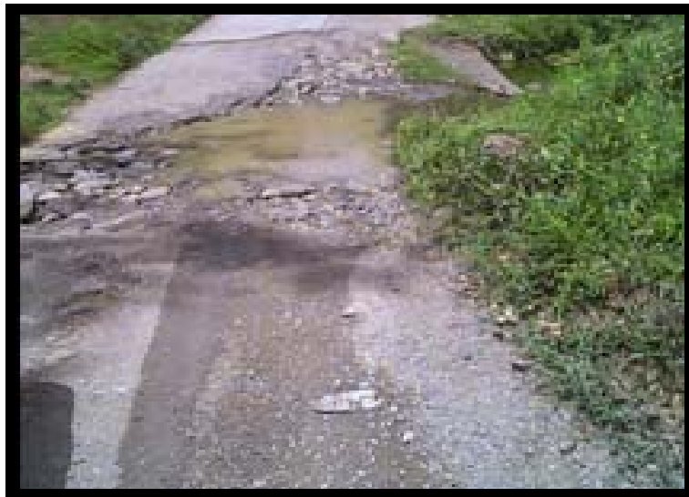
Figura 4.8 Progresiva 6+900. Demolición y construcción de bateas de iguales dimensiones.
