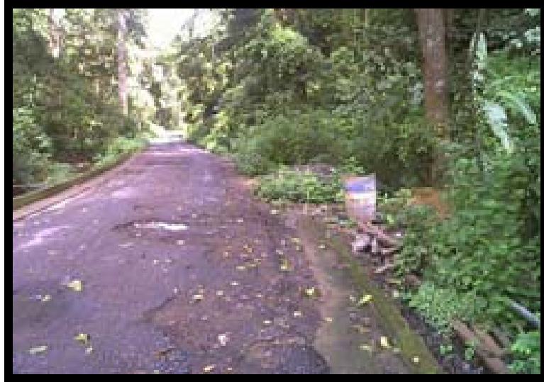
Figura 4.9 Progresiva 7+300. Tramo con pavimento asfáltico a ser demolido.
