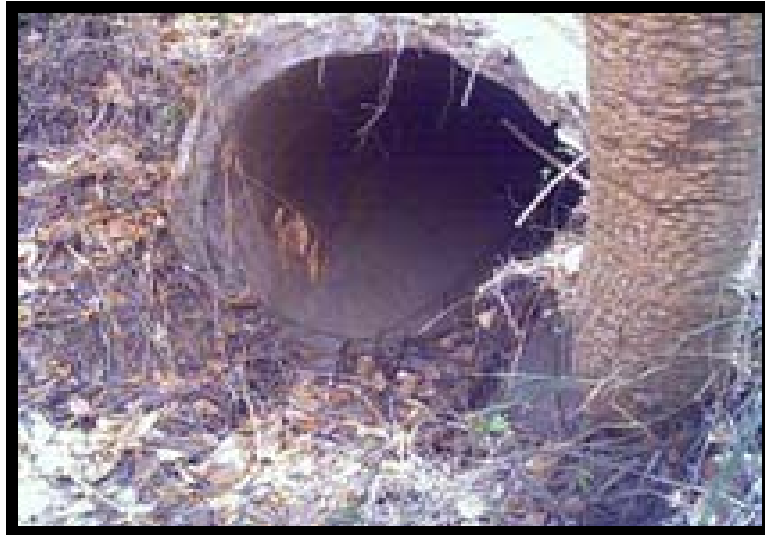
Figura 4.7 Progresiva 2+150. Construcción de cabezales de concreto.
