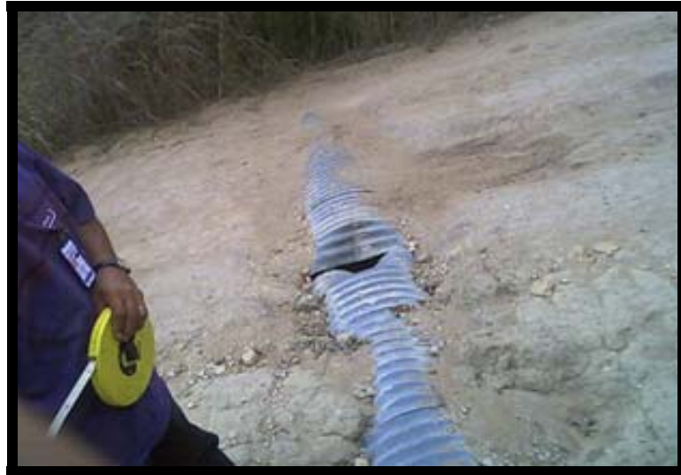
Figura 4.11 Progresiva 2+600. Tubería metálica a ser removida y sustituida por una batea.
