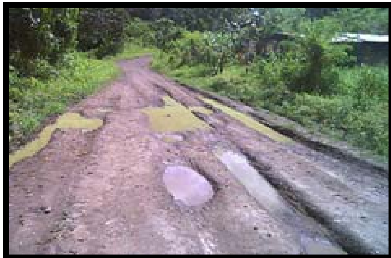
Figura 4.10 Progresiva 11+100. Tramo de tierra en malas condiciones donde amerita una batea de concreto armado y cunetas a ambos lados de la vía.
