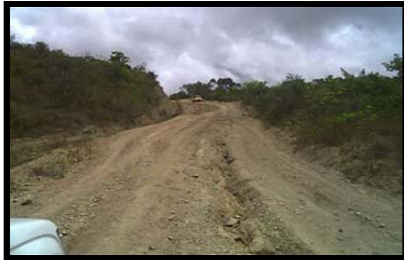
Figura 4.12 Progresiva 3+200. Acondicionamiento con tractor.
