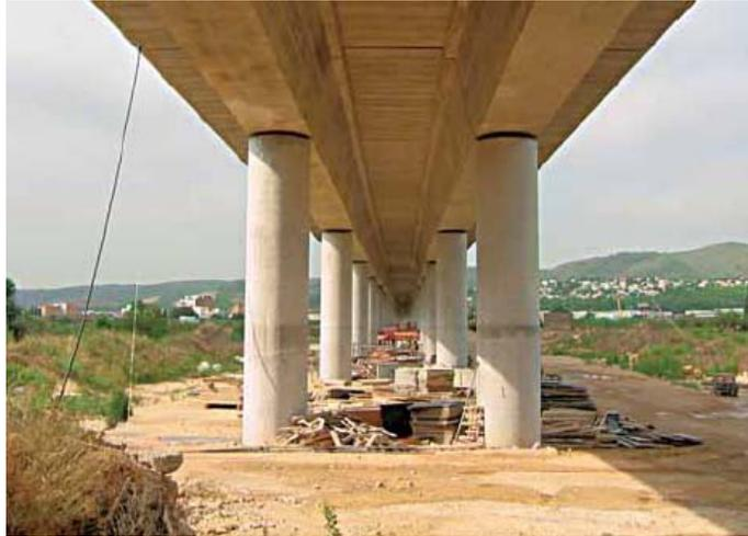
**Figura 3.5 Infraestructura de un Puente (Pilas).**
