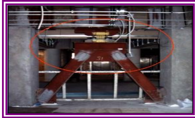
Figura 4.41. Disipadores de energía utilizada en las oficinas centrales del Instituto Mexicano del Seguro Social-México. [37]
