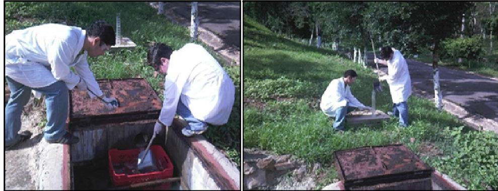
Figura 4.1 Medición de caudales y toma de muestra (punto de inicio).
