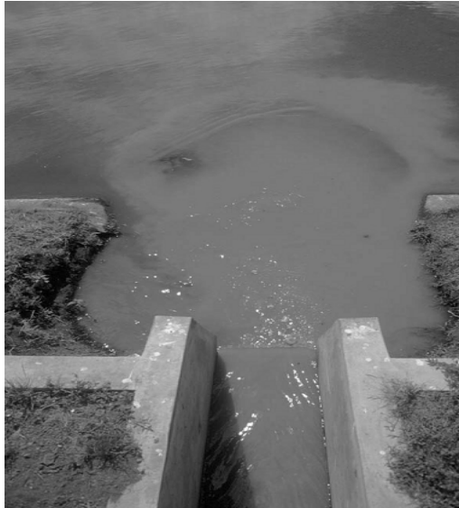
Fig. 2.8. Sólidos arenosos no removidos impiden la mezcla del afluente con el contenido de la laguna.
