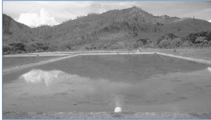
Fig. 2.1. Laguna anaeróbica en Honduras.
