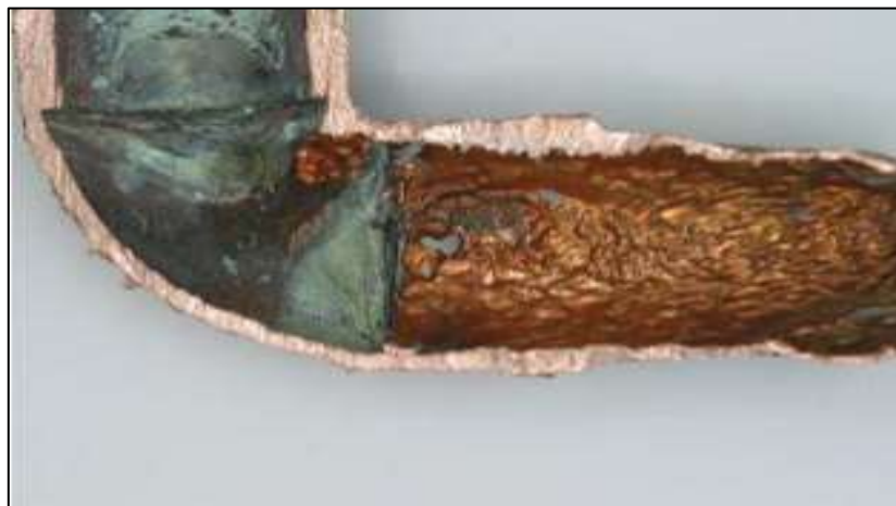
Figura 3.8 Ejemplo de erosión en las tuberías Fuente: Delgado, J. (2016)
