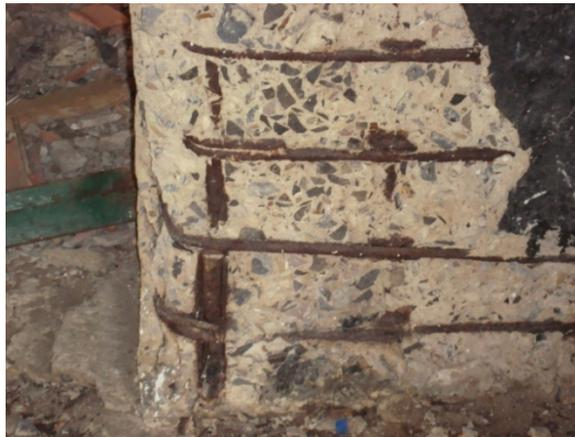
Figura 6. Corrosión del concreto y acero.
