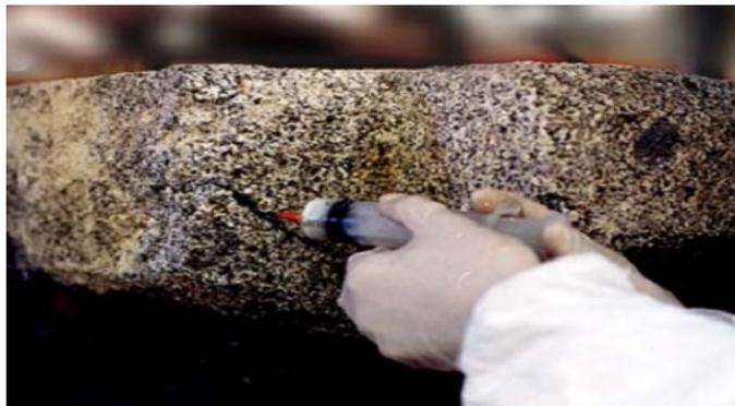
Figura 50. Inyección de resina epoxi fluidificada en el interior de la fisura. [24]
