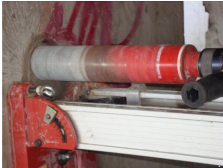
Figura 30. Extracción de núcleo en columna. (Fundeso)
