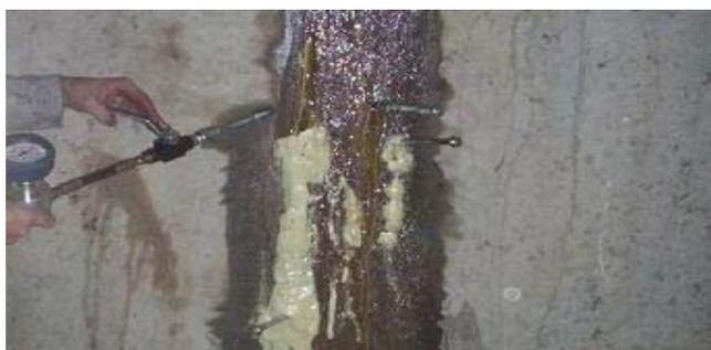
Figura 51. Trabajos de sellado y consolidación con presencia de agua mediante resina acrílica inyección. [25]
