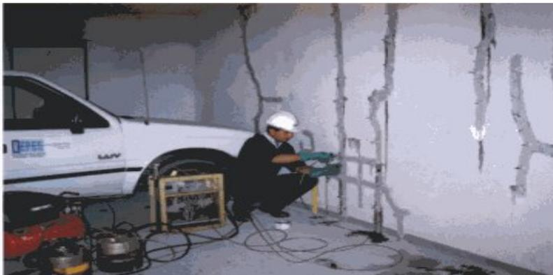
Figura 49. Reparación del agrietamiento con inyecciones epóxicas. [23]
