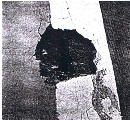
Figura 26. Disgregación del concreto producido por corrosión de armaduras. [11]
