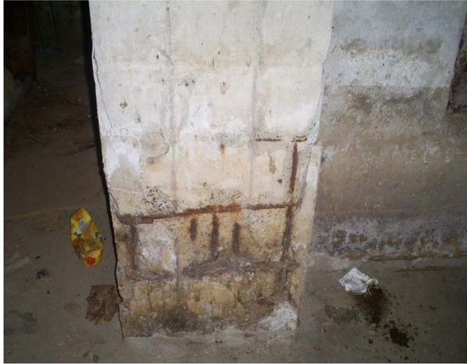
Figura 48. Corrosión del refuerzo metálico. (Fundeso).
