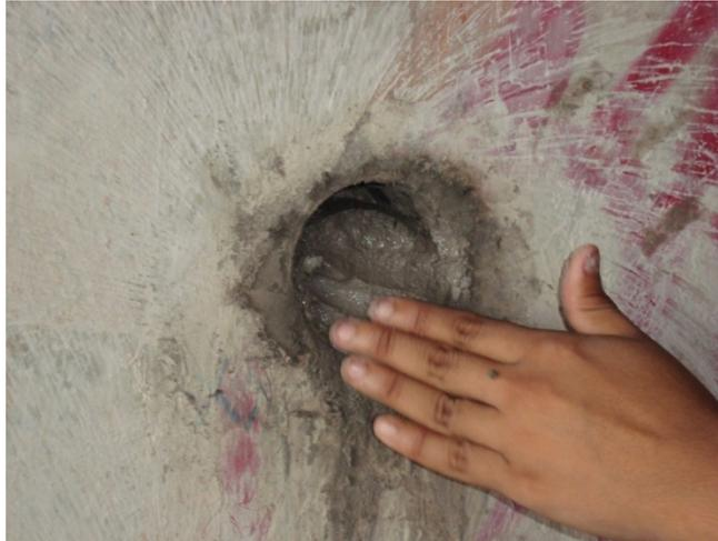
Foto 40. Mortero epóxico
