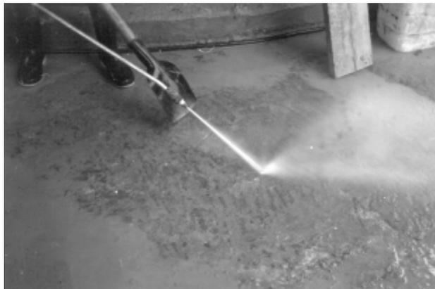
Figura 59. Preservación de una estructura de concreto mediante limpieza y lavado (mantenimiento preventivo). [5]
