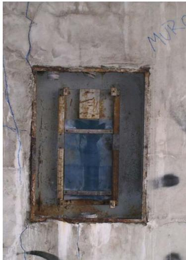
Foto 44. Pared agrietada y cajetín eléctrico corroído.
