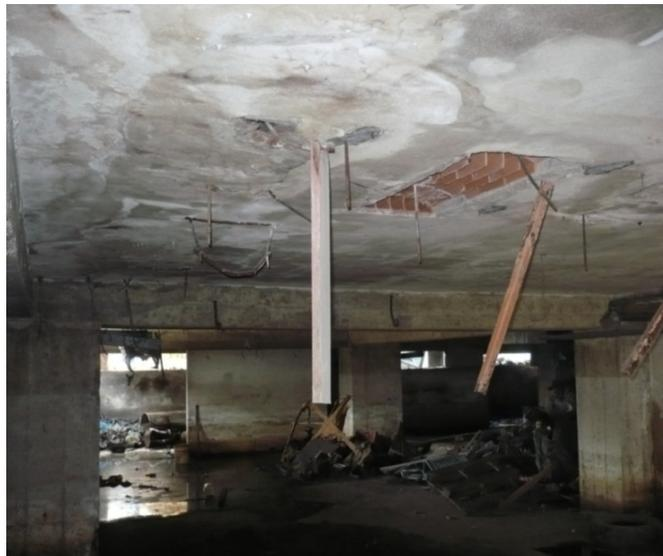
Foto 8. Daño en losa de semisótano
