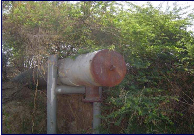
Fig. 4.1. Tapón de la Tubería de  $\phi$  30" en Puento Gómez.
