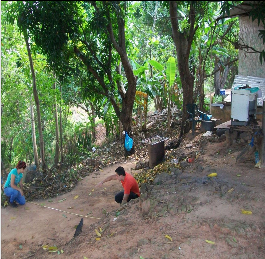
Figura 5.11 Cárcava dentro del perímetro de las viviendas.
