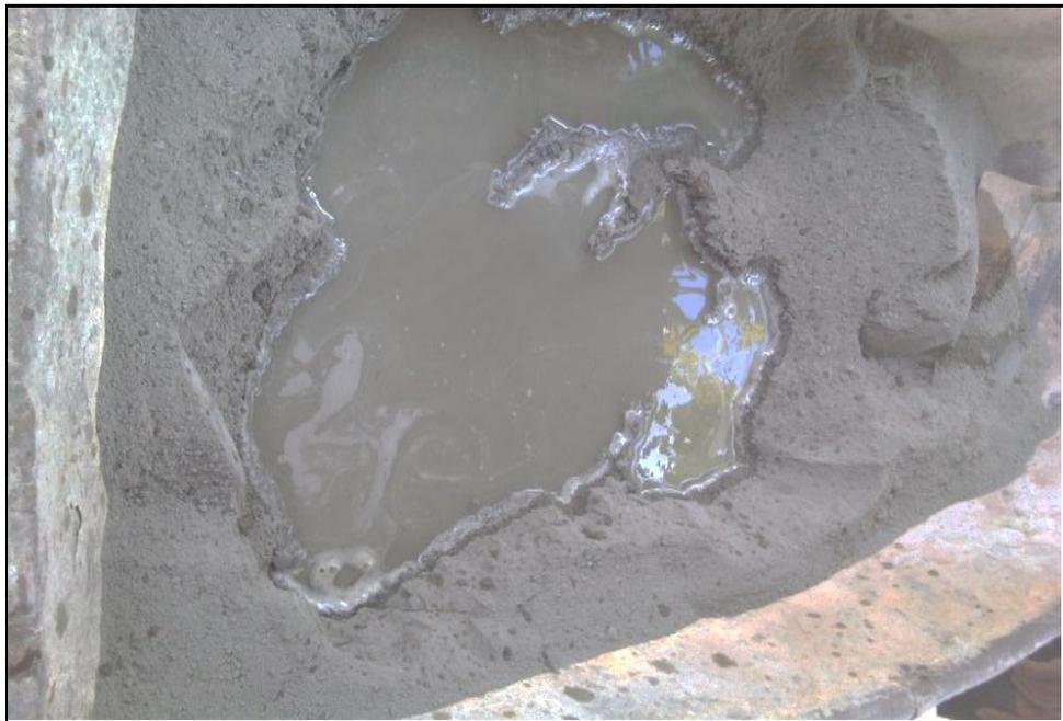
Figura 6. Agregamos el agua y batimos bien la mezcla para garantizar su homogeneidad.
