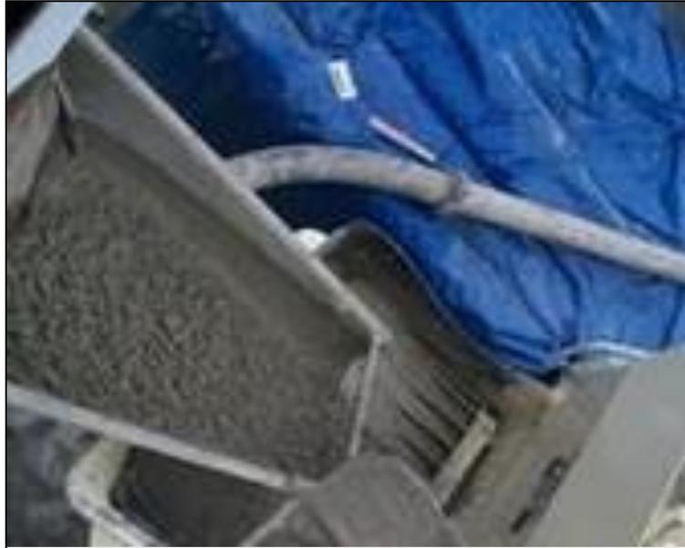
Figura 3.5. Mortero en estado fresco (www.mixercon.pe).
