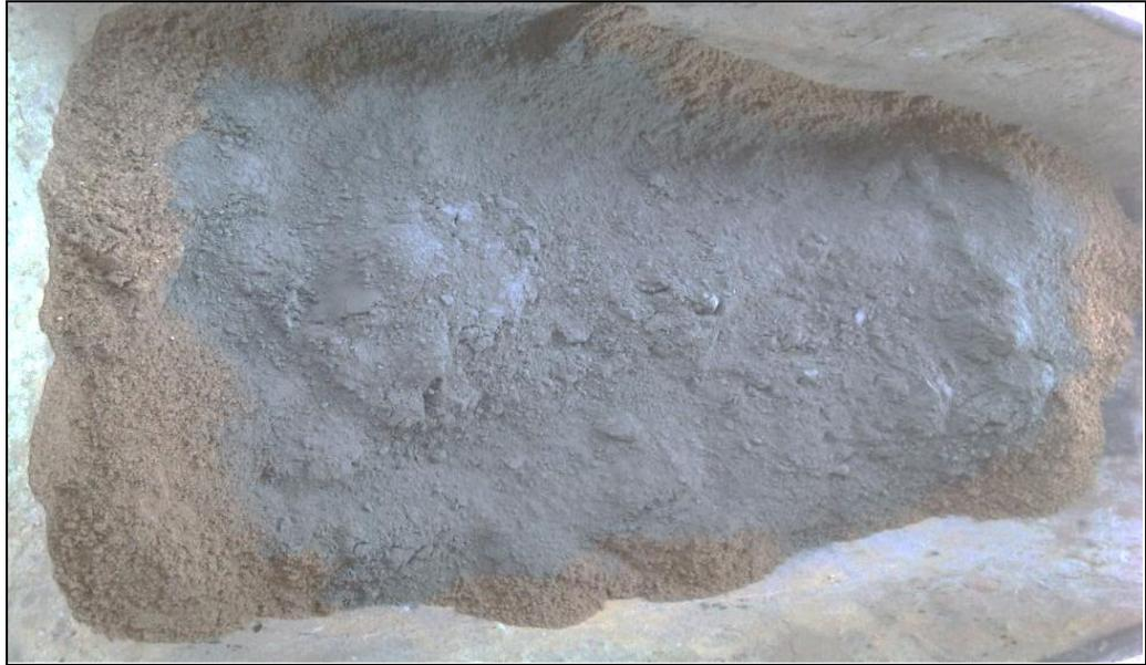
Figura 5. Añadimos el cemento en su totalidad y mezclamos para obtener una buena distribución de los componentes.
