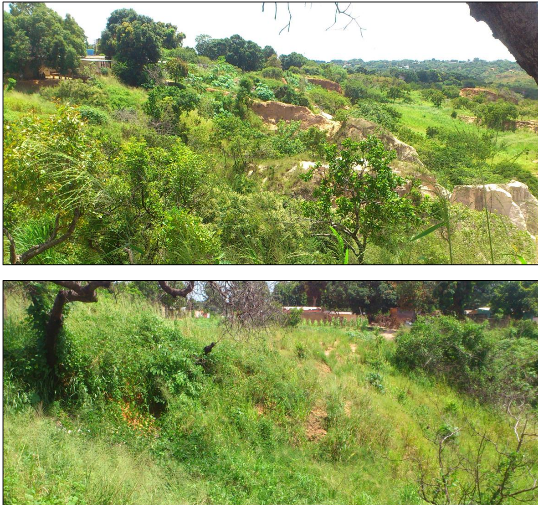
Figura 2.5 Viviendas construidas en el borde de las cárcavas del sector El Mirador.
