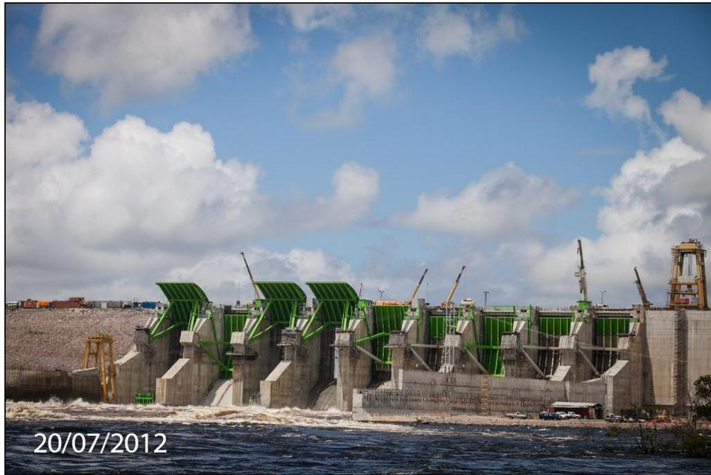
Figura F.1 Vista Aguas abajo del Macro – componente Aliviadero.
