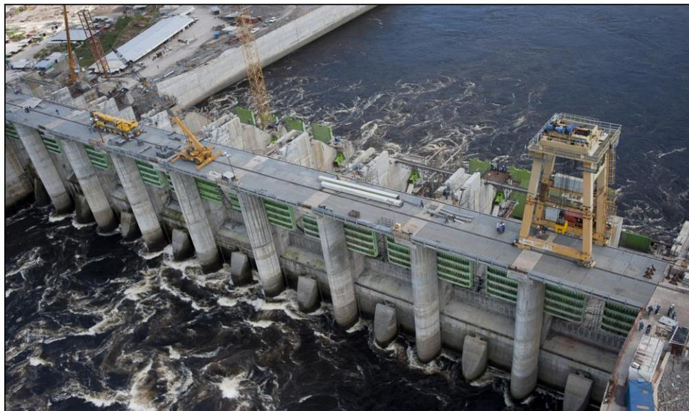
Figura F.2 Vista Aguas arriba del macro – componente Aliviadero.
