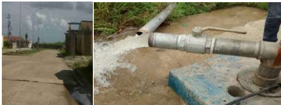
Figura 8. Condiciones actuales del Pozo 3 de la Zona Sur Urbana (ZSU) Urbanización Lomas del Viento, parroquia San Simón Rural
