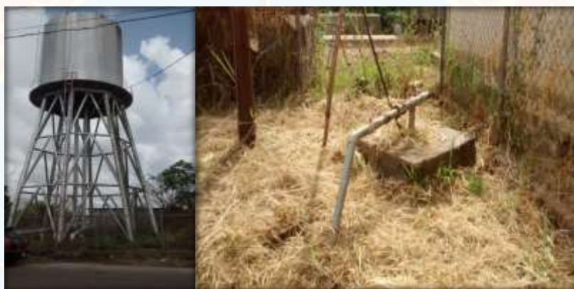
Figura 13. Condiciones actuales del Pozo 8 de la Zona Oeste Rural (ZOR) sector San Vicente parroquia San Vicente.
