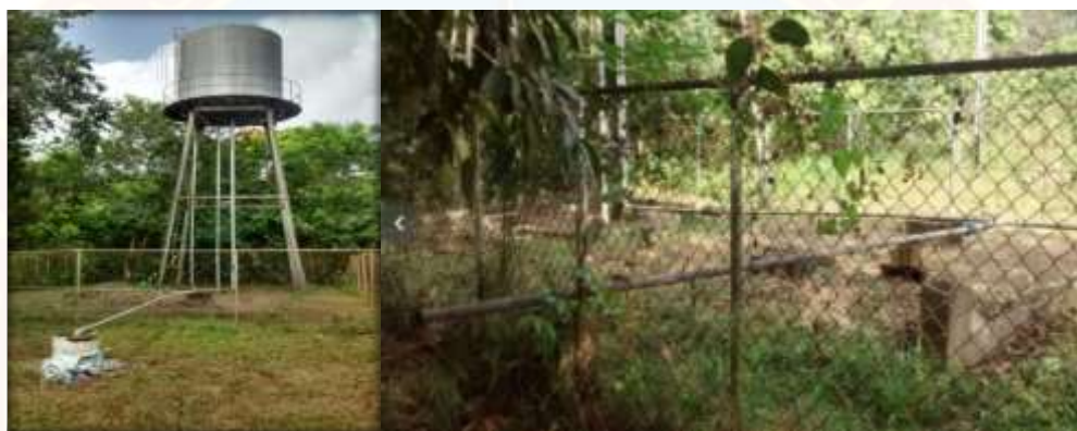
Figura 7. Condiciones actuales del Pozo 2 de la Zona Norte Rural (ZNR), Sector Plantación de Viboral, parroquia Boquerón.
