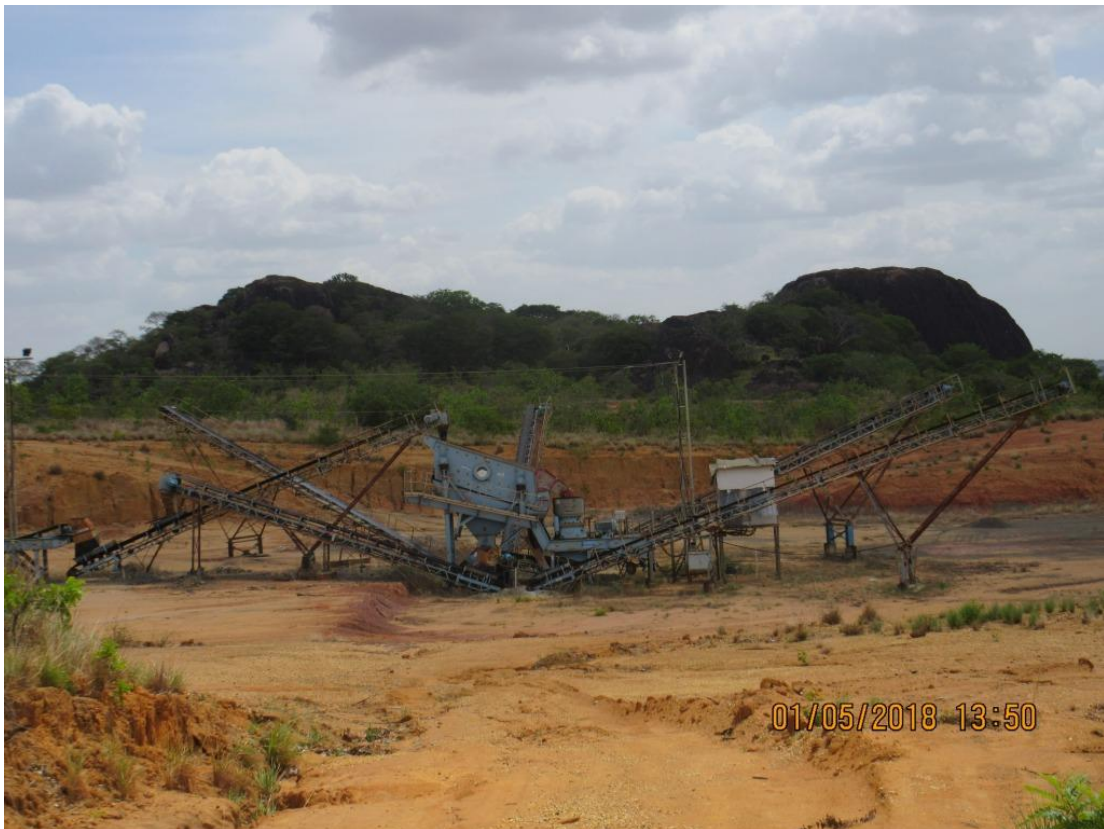
Figura 4.3 Tolva para la explotación de agregados de construcción, a partir de arenas y gravas de la Formación Mesa.
