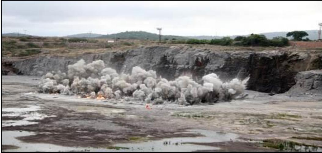
Figura 5.1 Voladura realizada para la construcción del canal de descarga del complejo hidroeléctrico Manuel Piar (Reyes, Rafael, 2012).
