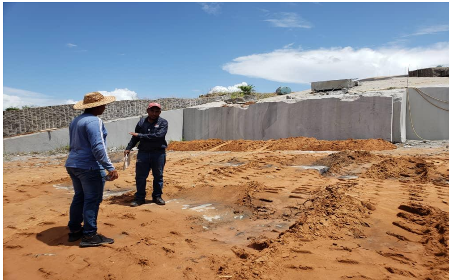
Figura 4.4 Visita a un frente de explotación. Nótese los cortes con hilo adiamantado.
