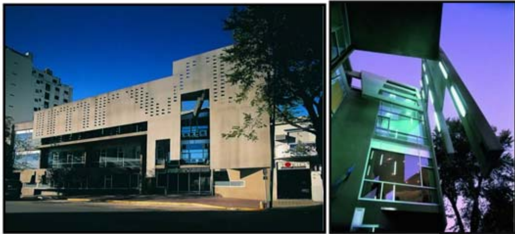
Figura 2.28. Instituto Municipal de Rehabilitación (IMRVL)
