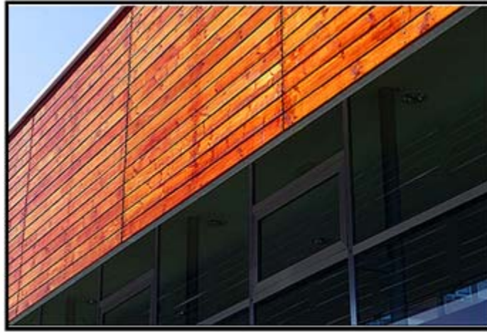
Figura 2.25. Material de fachada, centro de salud en Domaio.
