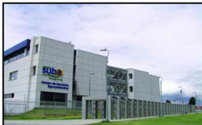
Figura 2.27. Hospital de Suba Nivel II
