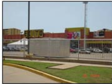
Figura 4.24. Acceso a la pasarela frente a el C.C. EXITO. Fuente: propia
