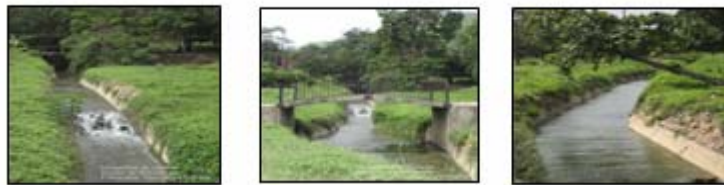
Figura 4.7. Canal de drenaje, que atraviesa la parcela dentro la sede del Núcleo de Anzoátegui de la UDO. Fuente propia.
