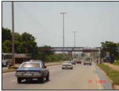
Figura 4.25. Pasarela frente entrada del núcleo. Fuente propia
