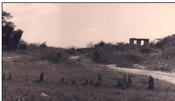
Figura N°3: Muñones de Tablestacado
