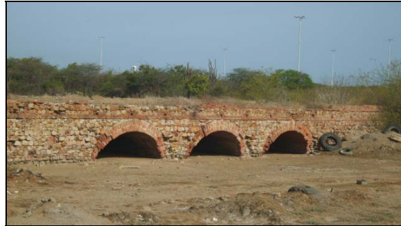
Figura N°5: Puente de tres Luces Municipio Simón Bolívar.
