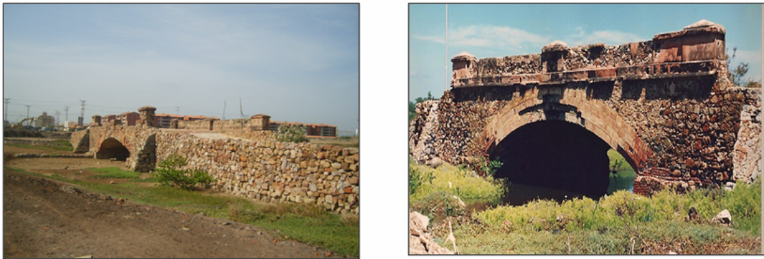
Figura N°34: Vista del Puente de una Luz, detalle del Arco de medio cañón truncado, el Municipio Bolívar.
