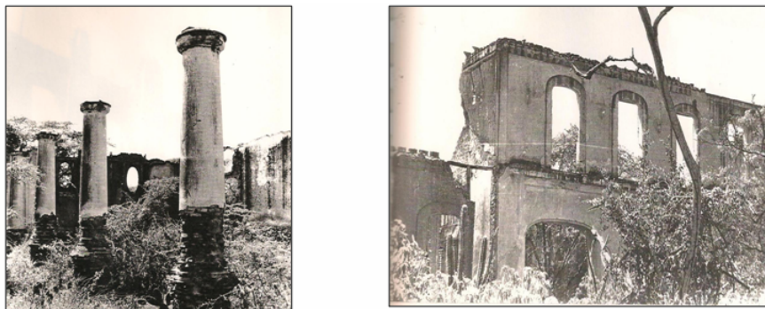
Figura N°32: Conjunto de columnas en el área central, Vistas de los grandes vanos de las puertas y ventanas de la aduana el Rincón:
