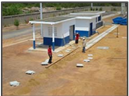
Camara de entrada.
