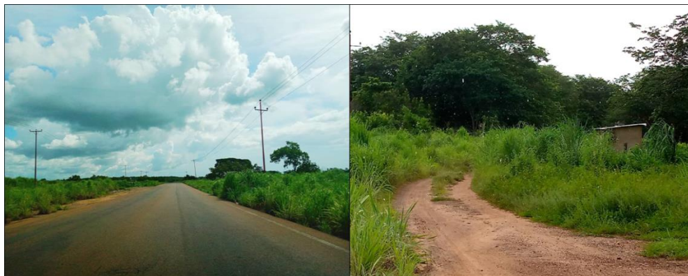
Figura 2.2 Carretera pavimentada troncal 19 (izquierda), vía de acceso sin asfalto al fundo (derecha).
