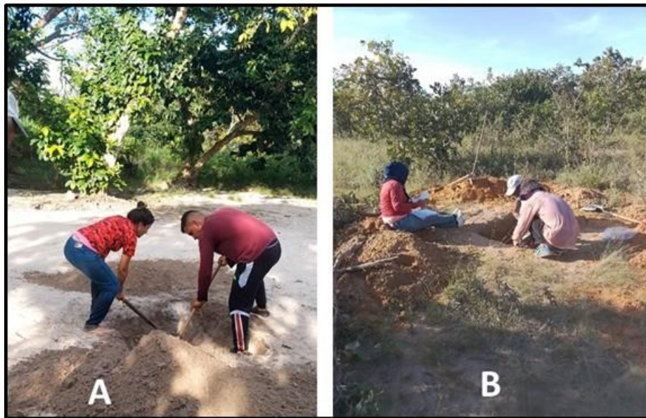
Figura 4.2 Actividad de apertura de calicatas (A) y descripción (B).
