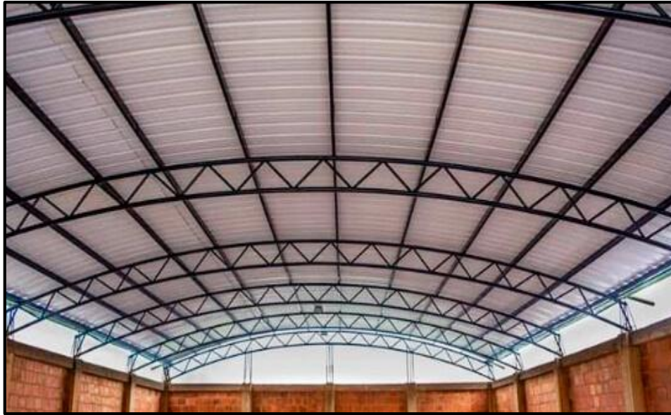
Figura 5.7 Techo de armaduras curvas con láminas de PVC
