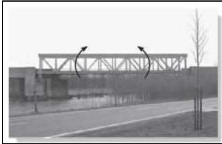
Figura 5.4 Armadura de puente
