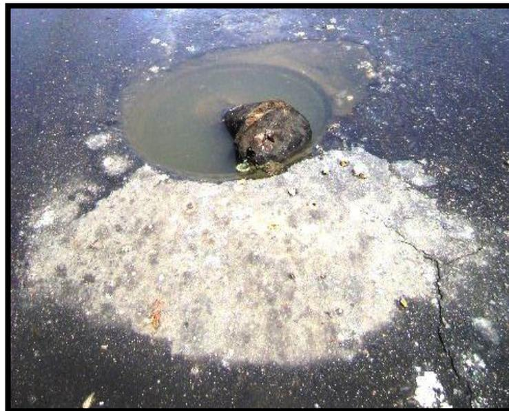
**Figura 5. 6: Estado de las bocas de visitas colapsadas del Sector Comando Fluvial.**
