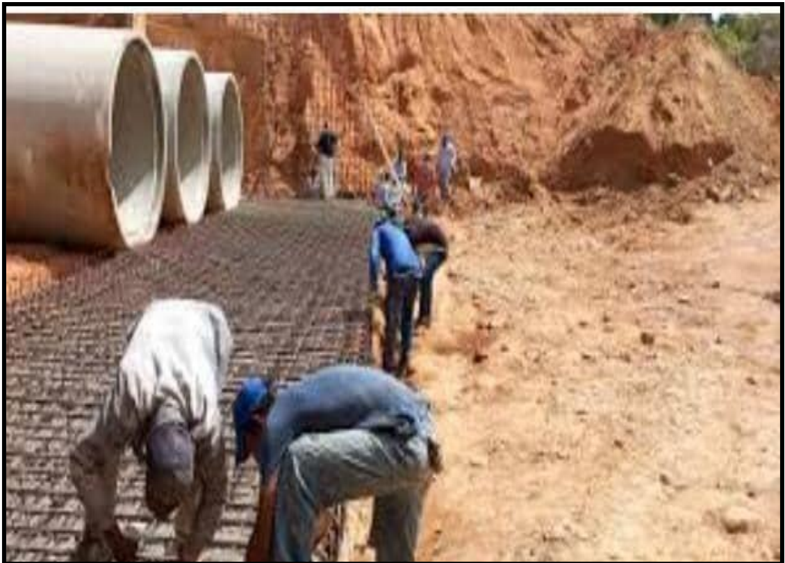
Figura 5.10. Construcción en el sitio
