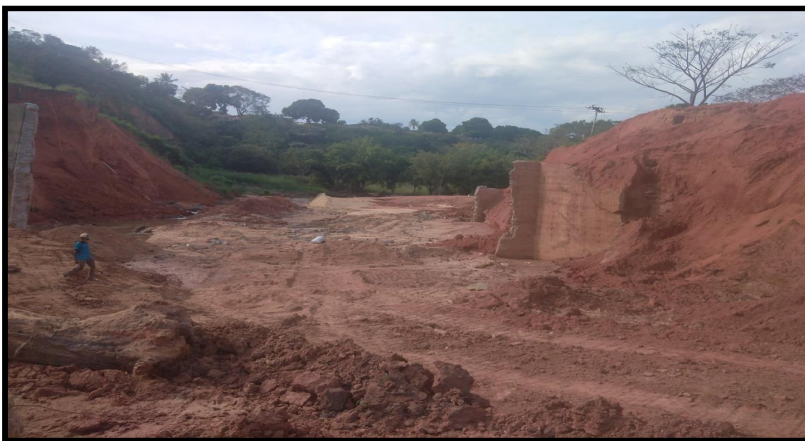
Figura 1.4. Movimiento de tierra en el sitio donde se construirá el Puente Primero de Mayo – Los Aceiticos.
