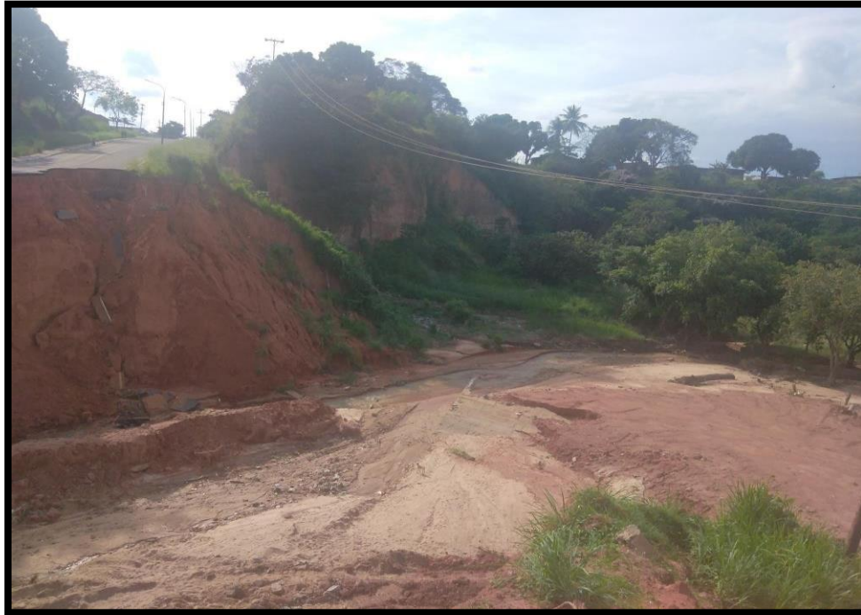
Figura 5.7. Cuerpo vegetal afectado en la Zona del Proyecto Civil.
