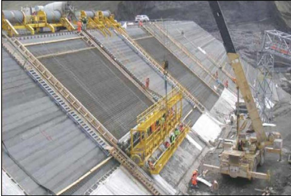
**3. 10 Proceso constructivo de una pantalla de concreto de hormigón (Sandoval, W. 2018).**
