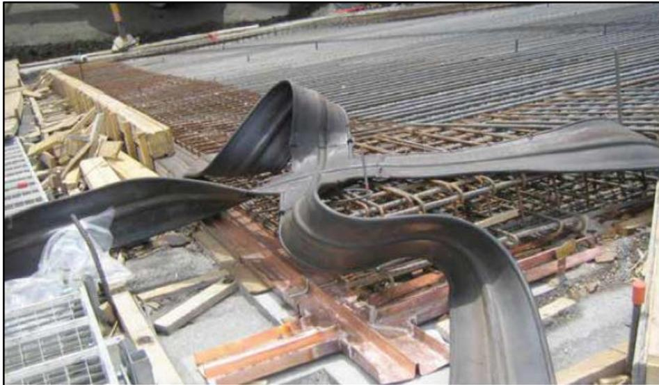
3. 11 Detalle de una junta de una pantalla de concreto (Sandoval, W. 2019).
