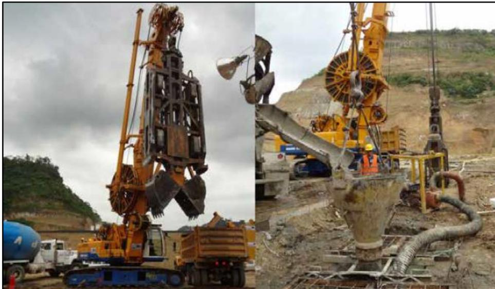
3. 13 Proceso de construcción de una pantalla de concreto plástico (Sandoval, W. 2019).
