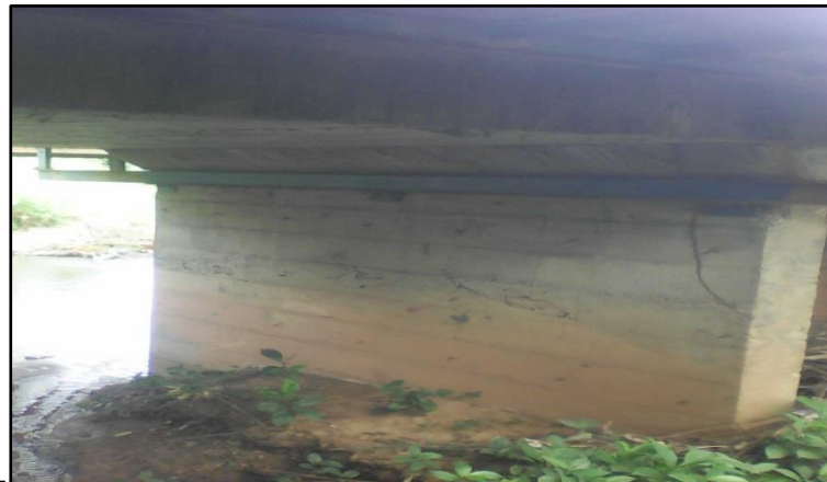
Figura 5.3 Soporte tipo losa y pila del puente Las Flores Norte.
