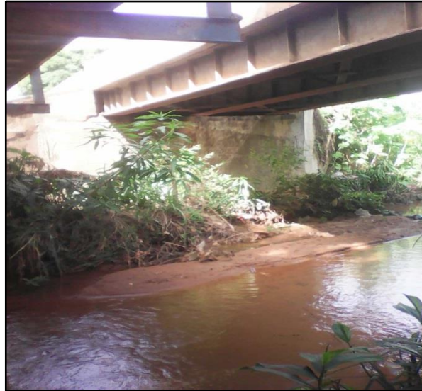
Figura 5.1 Estructura del puente Las Flores vista desde el río Santa Bárbara.
