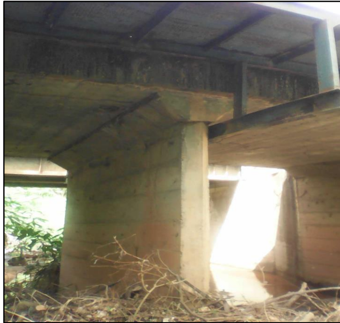
Figura 5.8 Pila y estribo oriental del puente
