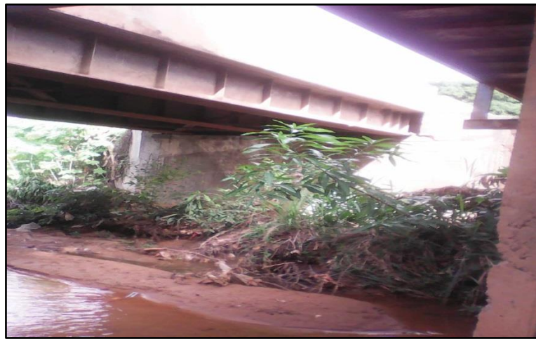
Figura 5.2 Vigas de soporte del puente Las Flores Sur.
