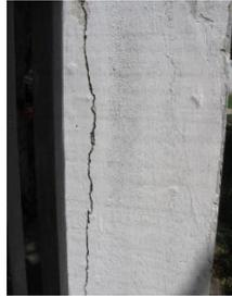
Figura N°6. Columna que sufre de agrietamiento. Fuente: Astorga, A y Rivero, P (2009).
