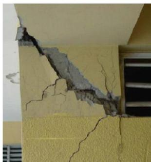
Figura N°14. Grieta por cortante en columna durante un evento sísmico. Fuente: Astorga, A y Rivero, P (2009).
