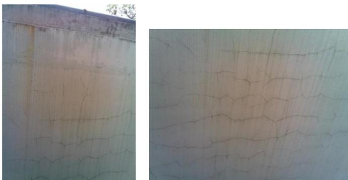
**Figura N°7. Fisuras en muro causadas por la exposición a la intemperie. Fuente: Astorga, A y Rivero, P (2009).**
