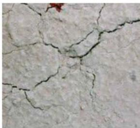
**Figura N°5. Apariencia típica de las fisuras por secado superficial del concreto.**
