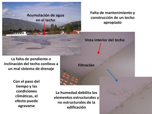
**Figura N°4. Filtraciones que causan humedad en techo de escuela venezolana. Fuente: Astorga, A y Rivero, P (2009).**
