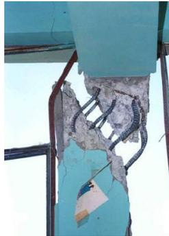
**Figura N°1. Colapso de las columnas, debido a la ausencia de estribos. Fuente: Astorga, A y Rivero, P (2009).**
