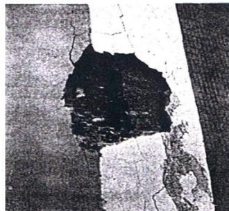
**Figura N°18. Disgregación del concreto producido por corrosión de armaduras. Fuente: Serrano, J y Silva, E (2010).**
